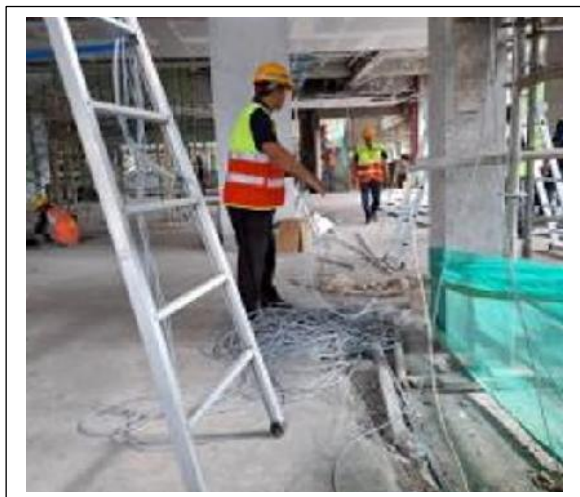
Gambar Proses Instalasi Internet Gedung Pascasarjana
